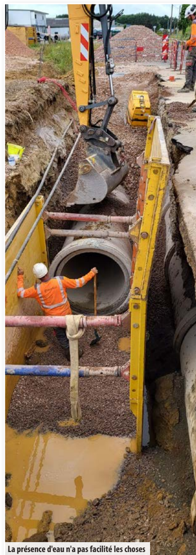
La présence d'eau n'a pas facilité les choses
