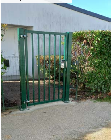
Portillon pour la sécurisation du lieu
