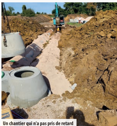
Un chantier qui n'a pas pris de retard
