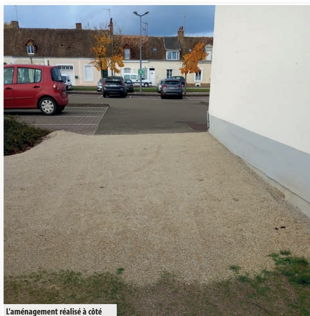
L'aménagement réalisé à côté
