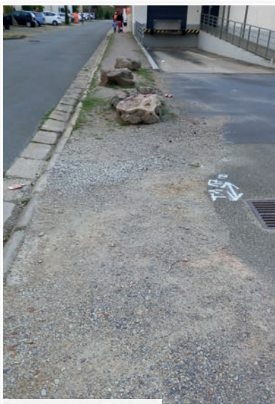
La rue Pasteur avant les travaux
