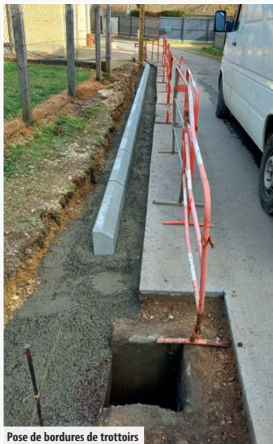
Pose de bordures de trottoirs
