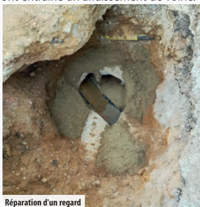
Réparation d'un regard
