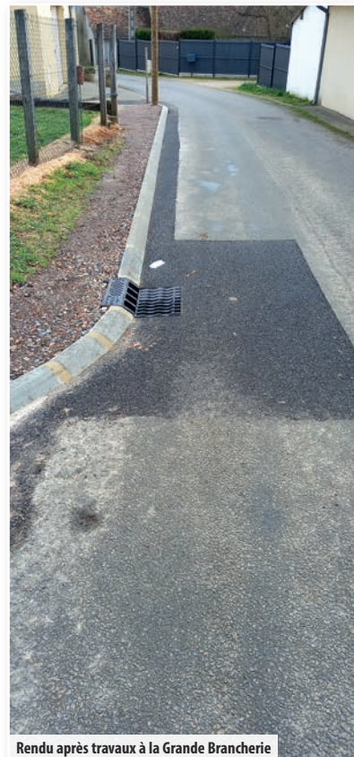
Rendu après travaux à la Grande Brancherie
