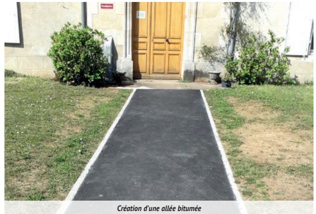
Création d'une allée bitumée
