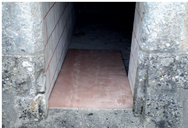
Création d'un accès PMR - Eglise d'Aulaine
