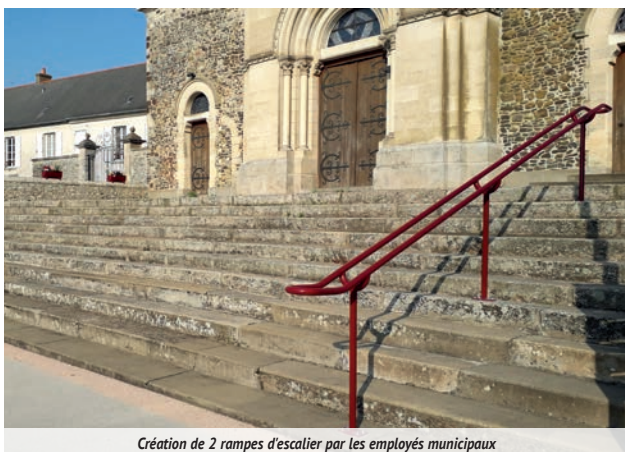
Création de 2 rampes d'escalier par les employés municipaux
