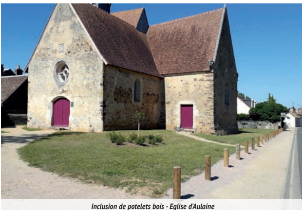
Inclusion de potelets bois - Eglise d'Aulaine
