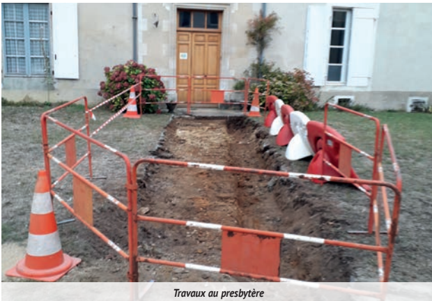
Travaux au presbytère
