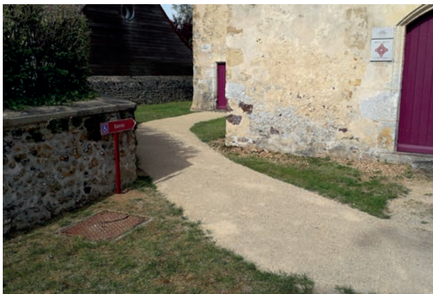
Création d'un cheminement PMR - Eglise d'Aulaine
