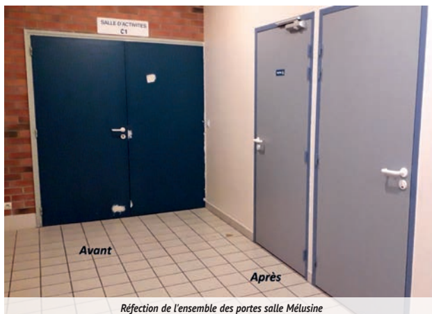
Réfection de l'ensemble des portes salle Mélusine
