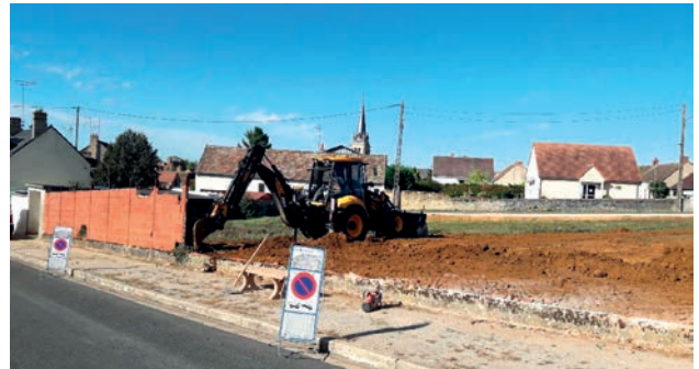
Déconstruction du mur qui menaçait ruine
