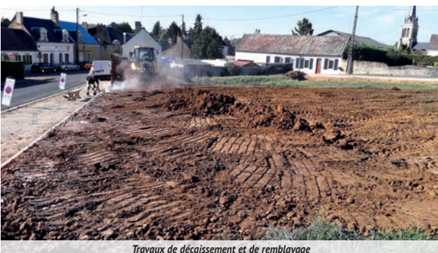
Travaux de décaissement et de remblayage
