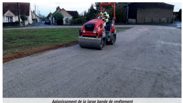
Aplanissement de la large bande de revêtement
