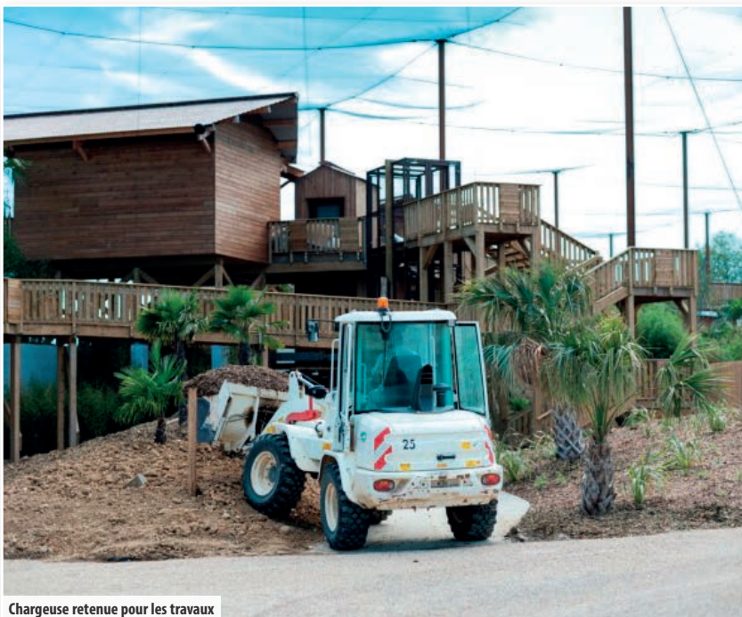
Chargeuse retenue pour les travaux
