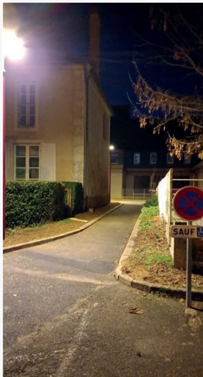
Réfection de l'éclairage public de la mairie pour les piétons
