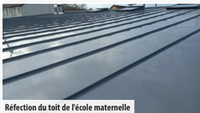
Réfection du toit de l'école maternelle
