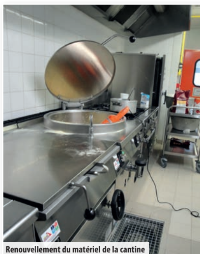
Renouvellement du matériel de la cantine
