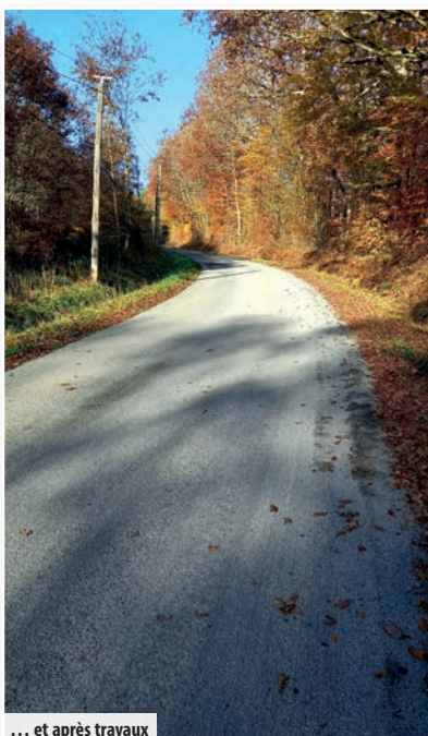
... et après travaux
