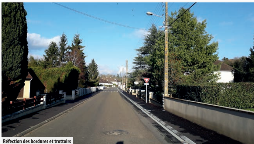
Réfection des bordures et trottoirs
