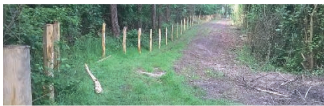
Restauration de chemins de randonnées et réalisation de plans
