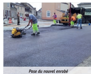
Pose du nouvel enrobé
