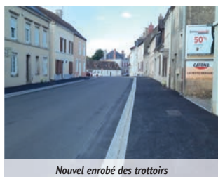
Nouvel enrobé des trottoirs
