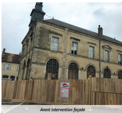
Avant intervention façade
