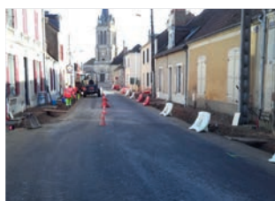
Les débuts du chantier
