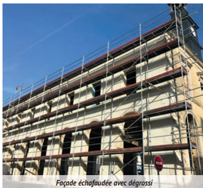
Façade échafaudée avec dégrossi
