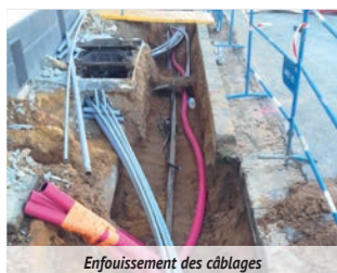
Enfouissement des câblages
