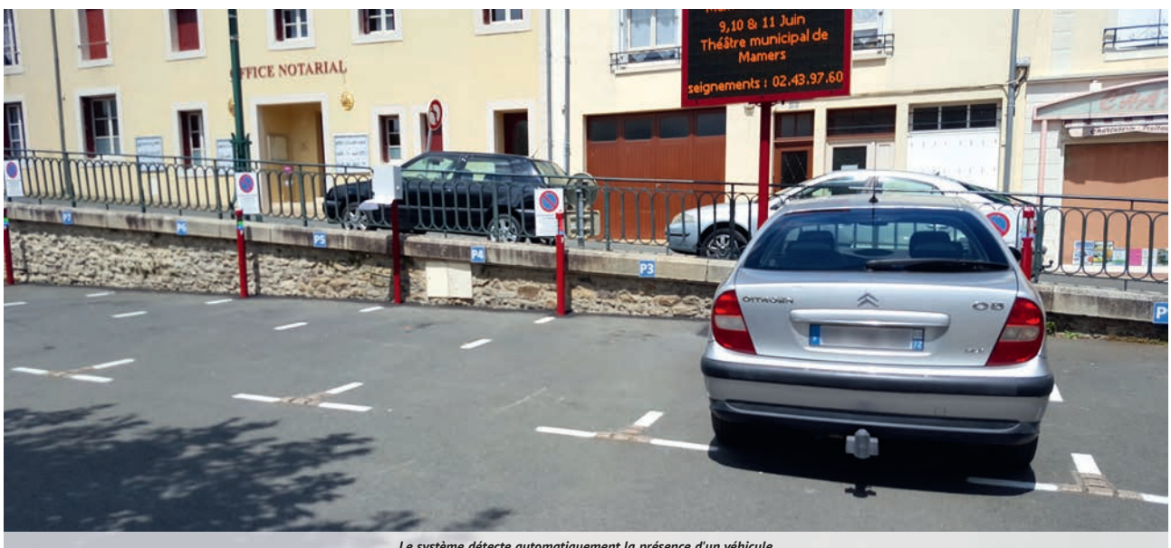
Le système détecte automatiquement la présence d'un véhicule
