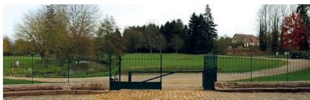
Restructuration des grilles du parc
