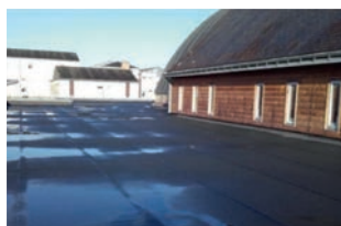
Etanchéité de la terrasse de la salle Mélusine
