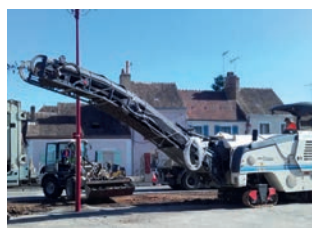
La machine à extraire le vieux bitume
