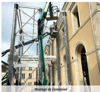
Montage de l'extension
