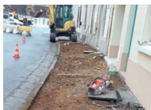
Les trottoirs ont été mis à nu
