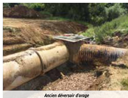
Ancien déversoir d'orage
