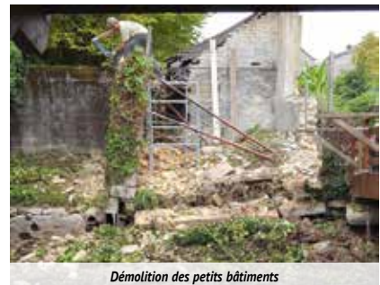
Démolition des petits bâtiments
