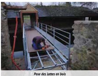
Pose des lattes en bois
