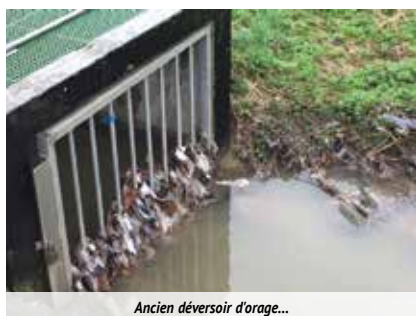
Ancien déversoir d'orage...
