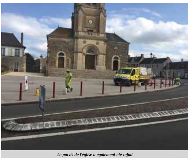
Le parvis de l'église a également été refait
