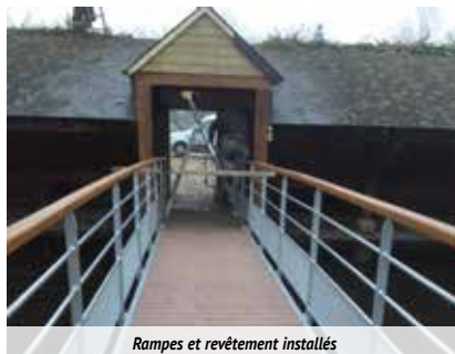
Rampes et revêtement installés
