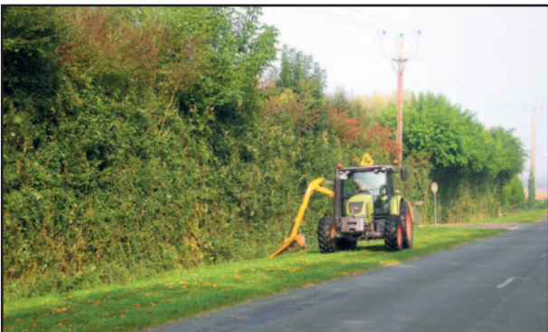
Nettoyage fossé et berne
