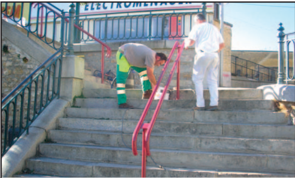
Réalisation et pose de rampes sur les marches Place du Marché
