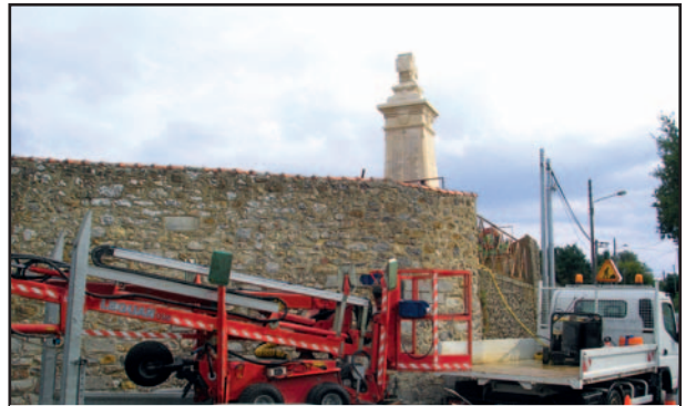
Nettoyage des monuments
