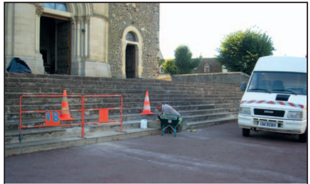
Réparation des marches de l'église
