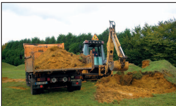
Suppression des buttes de terre, Rue Calmette
