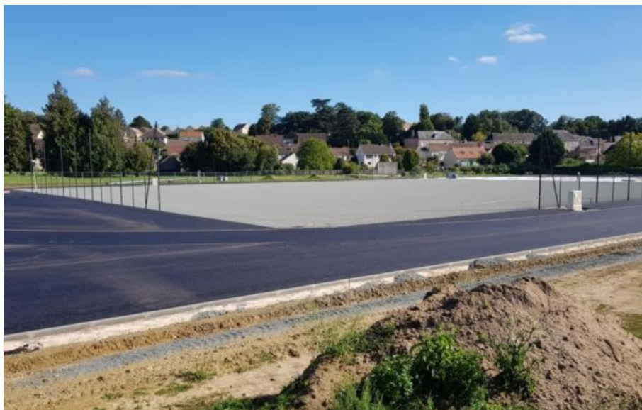
A Bonnetable, les travaux du stade Nonna Debonne avancent vite : il devrait à nouveau être opérationnel après les vacances de la Toussaint. © dr
