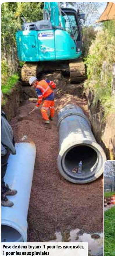
Pose de deux tuyaux 1 pour les eaux usées, 1 pour les eaux pluviales
